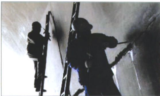
图2 直接堵漏法施工现场
