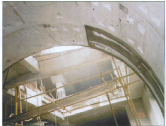
图3 某地铁隧道裂缝修补施工现场
